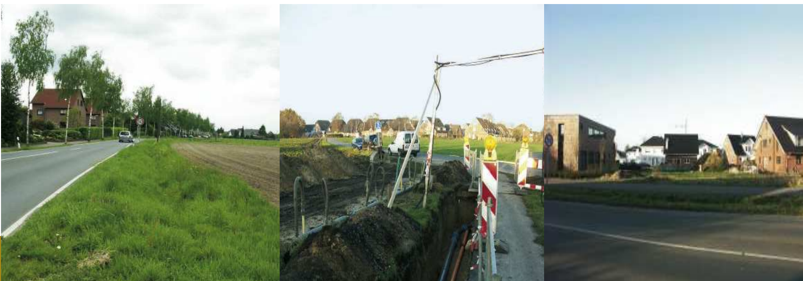
Das neue Baugebiet im Bocholter Ortsteil Biemenhorst an der Birkenallee vor, während und nach der Erschließung mit Energie und Trinkwasser
