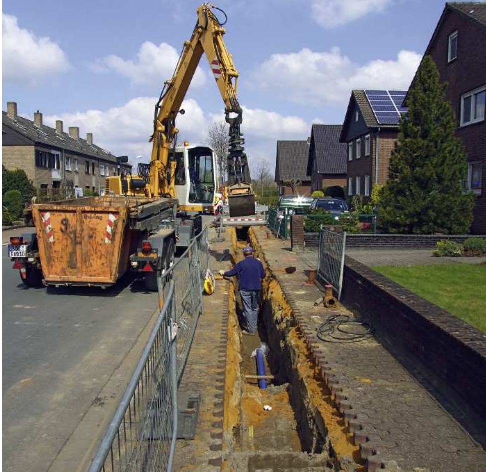
Bevor der erste Spatenstich zu einer Baumaßnahme erfolgen kann, wird eingehend geplant
