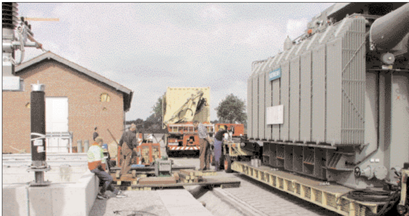
1- und 10-kV-Kabeleinbindung an der neuen 110-kV-Übernahmestation im Industriepark Bocholt-Mussum
