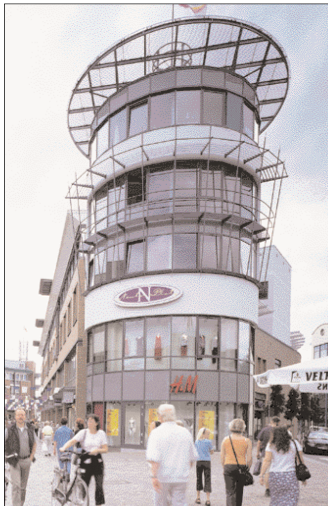
Mit Nahwärme versorgtes Einkaufszentrum in der Bocholder Innenstadt
