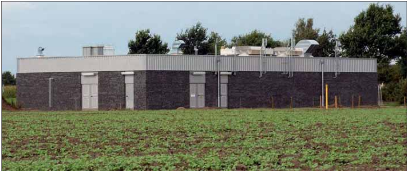
Der Erdgasröhrenspeicher ist Teil der Energiezentrale Bocholt-West. Bei ihr handelt es sich um eine Erdgas-Übernahmestation. Die Energiezentrale verfügt des Weiteren über eine Erdgas-Expansionsanlage.
