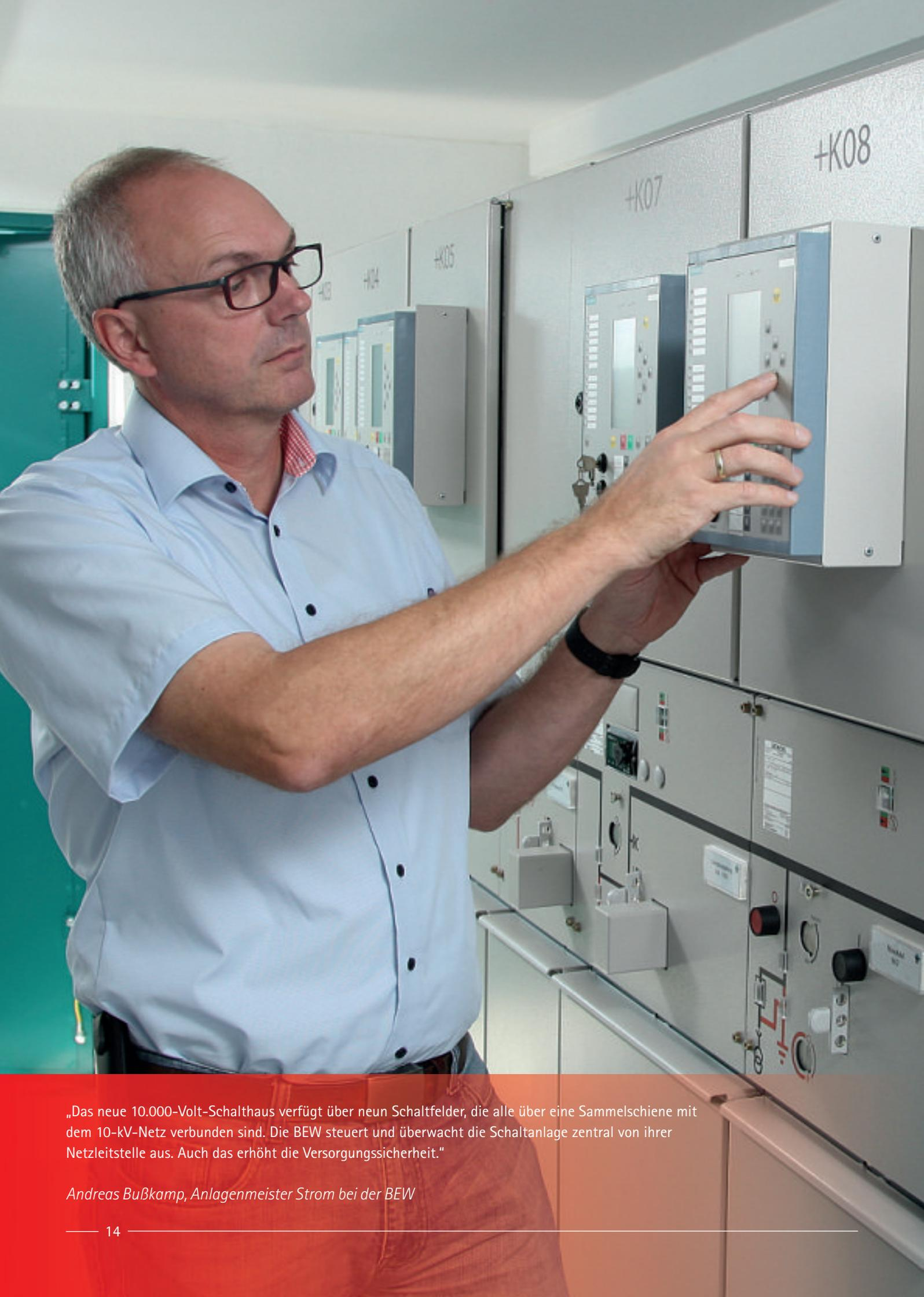
„Das neue 10.000-Volt-Schaltheis verfügt über neun Schaltfelder, die alle über eine Sammelschiene mit dem 10-kV-Netz verbunden sind. Die BEW steuert und überwacht die Schaltanlage zentral von ihrer Netzleitstelle aus. Auch das erhöht die Versorgungssicherheit.“
