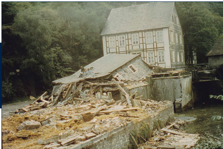
Ein Teil der alten Mühlengebäude wurde 1964 abgerissen.
