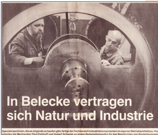
Spezialmaschinen, die es nirgends zu kaufen gibt, fertigt der Fachbereich Industriekomponenten im eigenen Betriebsmittelbau. Hier arbeiten die Mechaniker Paul Eichhoff und Hubert Schacke an einem Bedampfungssofen für das Beschichten von Kopiertrommeln.
