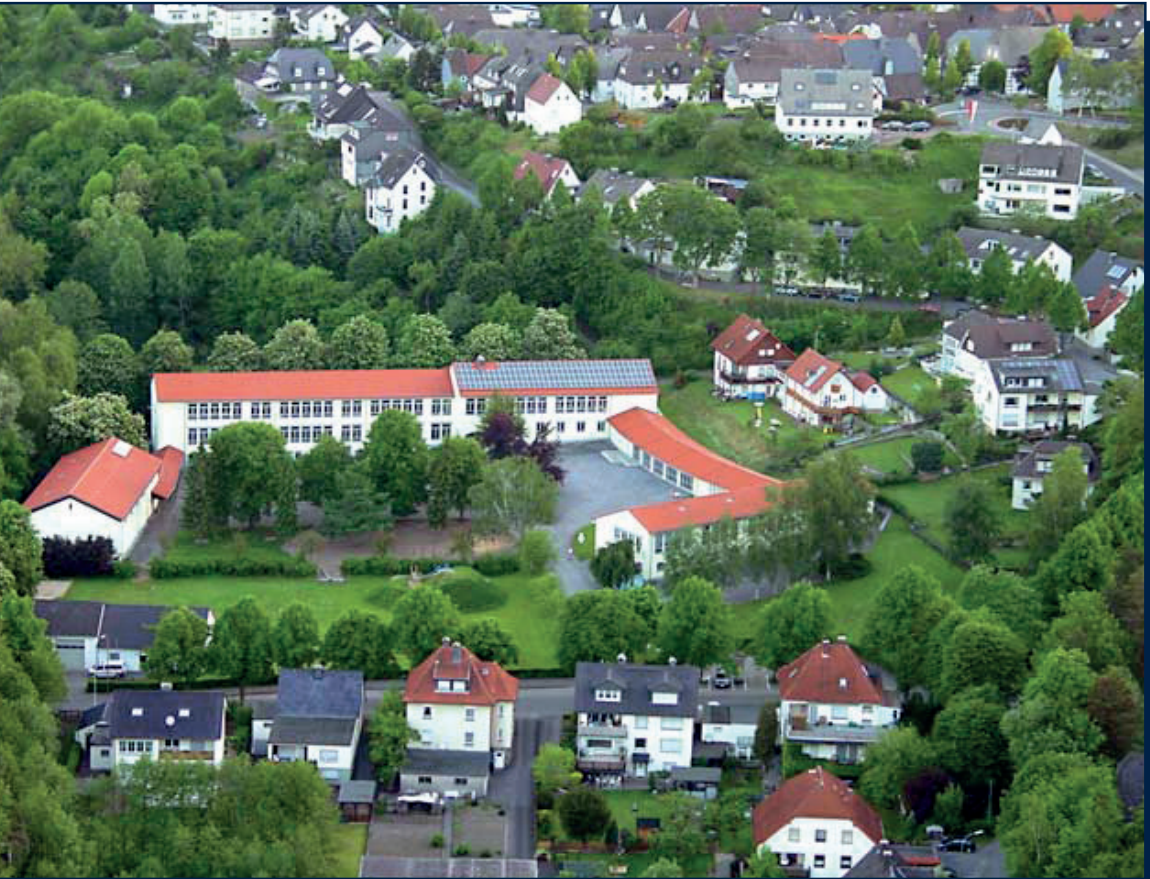
Die heutige Westerberg-Grundschule wurde 1953 als Volksschule errichtet. (Foto: Gerd Flaig 2006)
