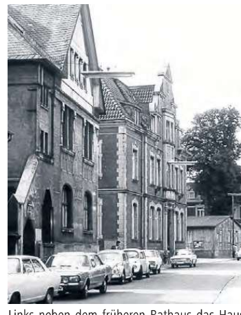
Links neben dem früheren Rathaus das Haus Frauenstraße 18, das, bedingt durch die Gründungsarbeiten, baufällig und abgerissen wurde. Im Hintergrund die Amtsbaracke.
