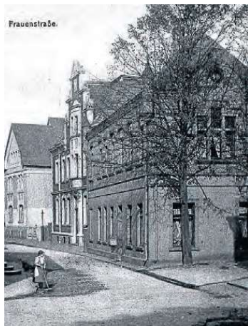
Das 1878 erworbene Privathaus (vorne) wurde zum Verwaltungsgebäude umgebaut, dann im Herbst 1942 abgerissen.
