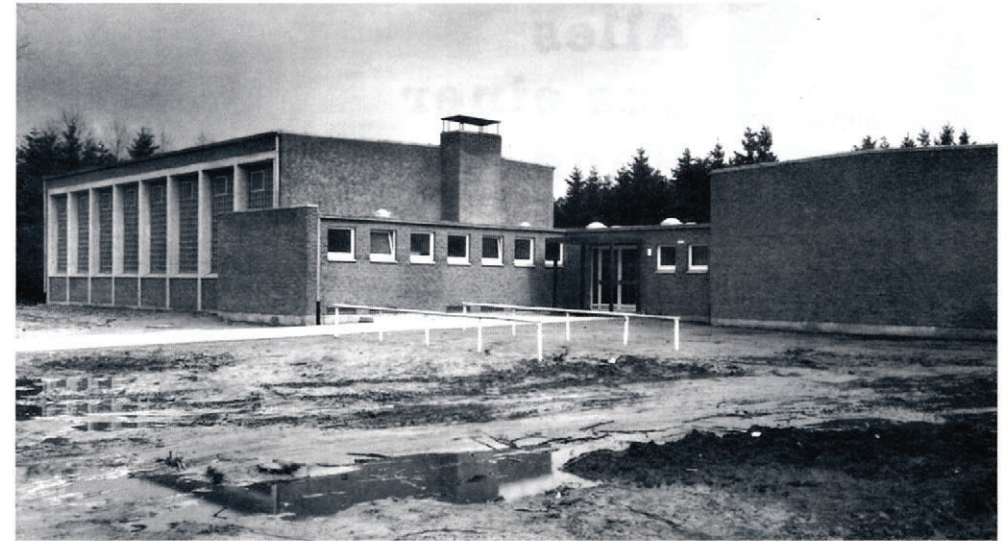
Turnhalle und Lehrschwimmbaden an der Holzhofstraße im Jahr 1967
