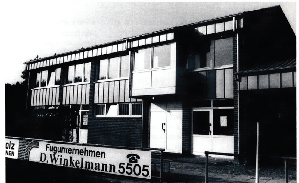
Rechtzeitig zum 75jährigen Bestehen der Victoria wurden jetzt die neuen Umkleiden und das Vereinsheim am Holzhofstadion fertiggestellt.
