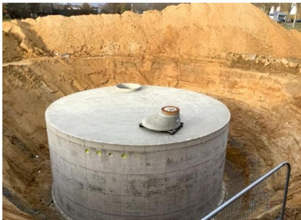
Abb. 2: Wasserspeicher des Neubaus.
