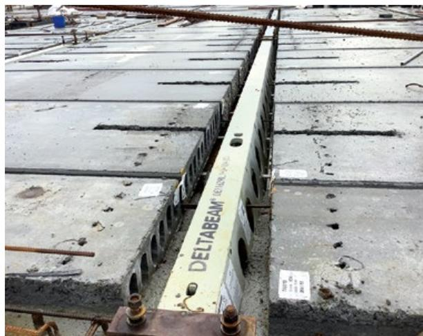
Abb. 4: Hohe Deckenbelastbarkeit durch Hohlkammerdecken-Fertigteile zwischen Deltabeam-Stahlträgern.
