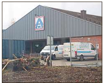
Die Arbeiten für den neuen Aldi-Markt in Neubeckum sind gestartet. Foto: mo
