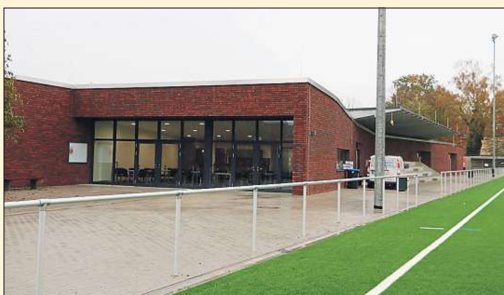
Mittig steht das neu errichtete langgezogene Vereinsheim nun zum Fußballplatz im Ahlener Süden.
