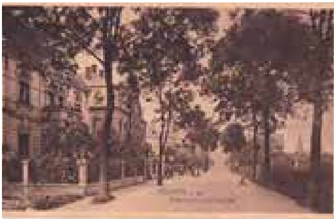
Hüsten Rönkhäuserstraße (heute Heinrich-Lübke Straße) um 1910
