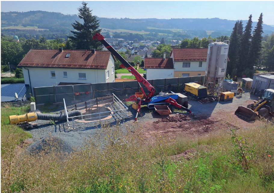
Abb. 3: Baustelleneinrichtung und Schachtmundloch. © Bergamt Nordbayern
