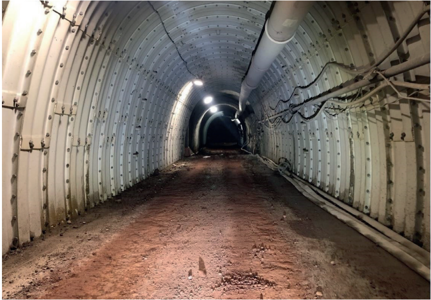
Abb. 7: Umfahrung vom Christopherschacht aus mit Stahlausbau. © Bergamt Nordbayern
