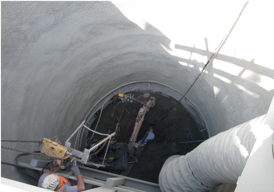
Abb. 5: Schachtbauarbeiten am St. Katharina Förderschacht. © Bergamt Nordbayern
