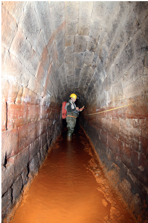
Abb. 2: Sandsteingewölbe des K. B. Maximilian Erbstollens. © GolHo
