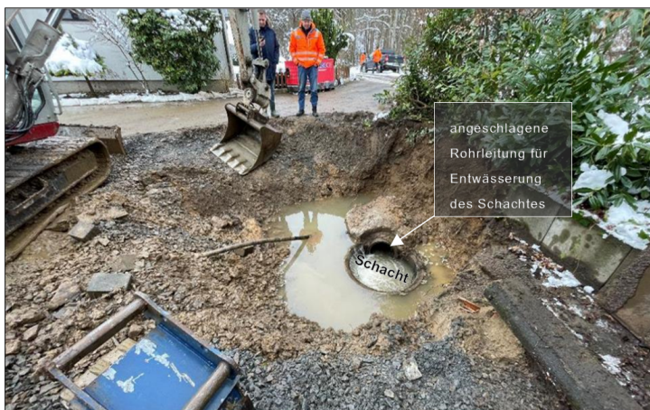
Abb. 2: freigelegter Schachtkopf des Entwässerungsschachtes.
