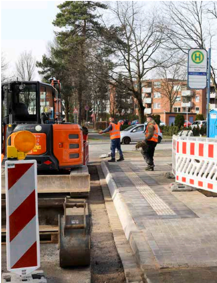
Im Februar haben die Stadtwerke die Haltestelle Heinrich-Kindsgrab-Straße barrierefrei ausgebaut.
