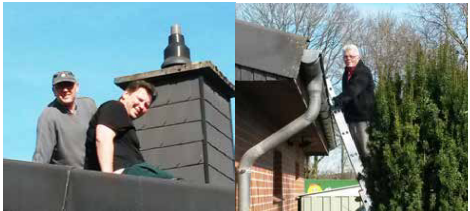
„Auch kleinere Reparaturen auf dem Dach und das Ausmisten des Dachbodens gehören dazu“.
