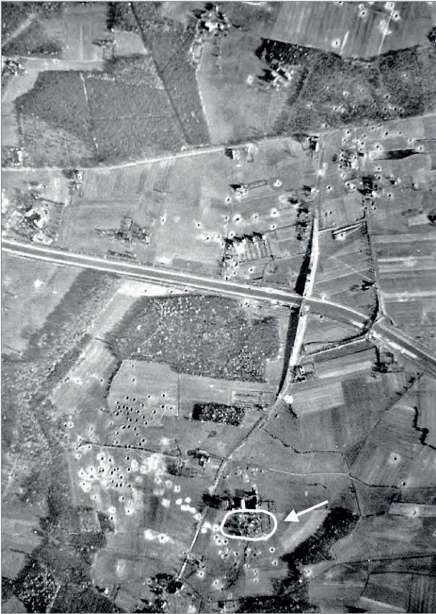
Luftbild von der Hofstelle Kranefoer/Mertenskötter von den Alliierten vermutlich gegen Kriegsende 1945 aufgenommen
