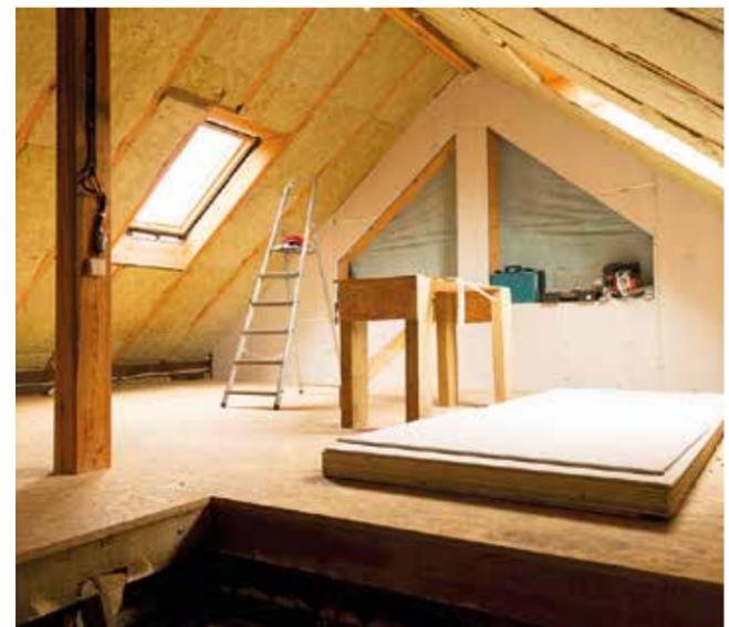
Mineralwolle ist für den Dachausbau optimal geeignet. Der Hochleistungs-Dämmstoff spart nicht nur viel Heizenergie, sondern verbessert auch den Brand- und Schallschutz erheblich. Der Staat unterstützt diese Leistungsfähigkeit mit deutlichen finanziellen Zuschüssen im Rahmen einer energetischen Sanierung.
