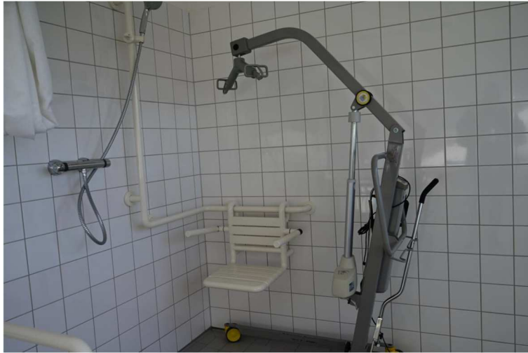
Dorsten, Haldenwangschule, Pflegeraum mit Dusche, WC, Lifter
