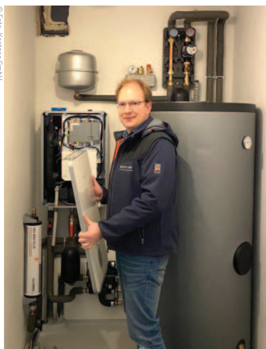
Christian Degner erklärt, wie eine Wärmepumpe funktioniert.
