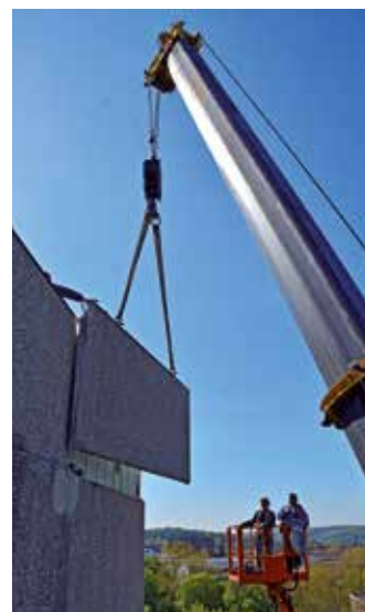
Die Demontage der Waschbetonplatten am Westgiebel des Krankenhauses Witten hat begonnen. Foto: Hubert Schmölzl
