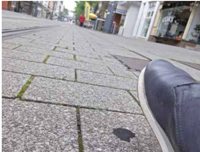
Wie mühsam die Reinigung der Gehwegplatten trotzdem noch ist, zeigte das Betriebsamt bei einem Pressestermin vor Ort. Vom Ergebnis darf man aber nicht zu viel erwarten. Foto: THS
