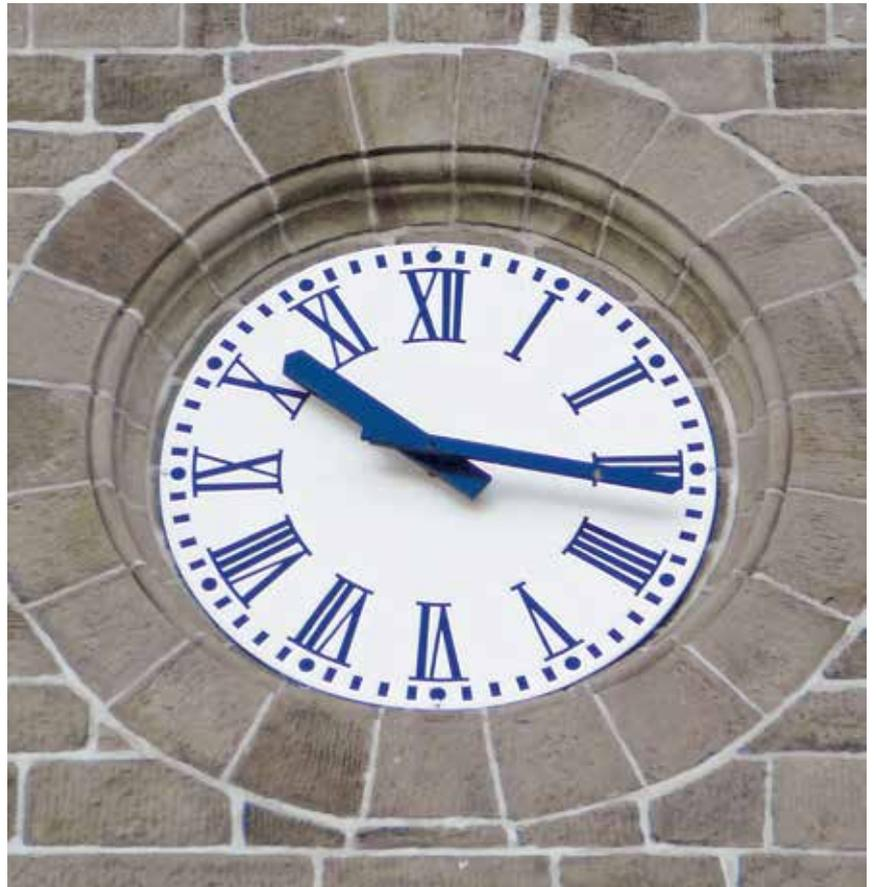
Die Turmuhr wird von der Uhr im Eingangsbereich gesteuert, es wird ein elektrischer Impuls geschickt. Hinter dem Ziffernblatt im Inneren sitzt das „Zeigerwerk“, ein Metall-Kasten, ungefähr in der Größe eines Schuhkartons.
