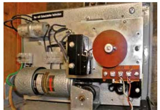
Die Turmuhr-Ansteuerung ist ein etwa schuhkartongroßer Metall-Kasten, der die Bewegung über Antriebswellen und Zahnräder auf die Uhrzeiger-Achse überträgt. Gesteuert wird er von einer Mutteruhr.
