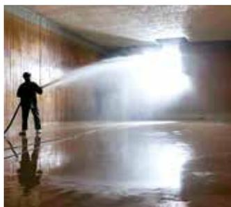
Oben drüber ist alles fertig, nun werden die Innenwände der Trinkwasserbehälter auf dem Helenenberg neu verkleidet.
