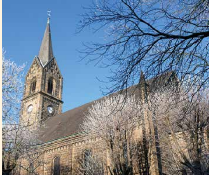
Die neue Erlöserkirche der evangelischen Gemeinde in Annen an der Westfeldstraße 81.
