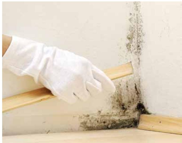
Bei freistehenden Häusern älterer Bauart sind die Raumecken der Außenmauern anfällig für Schimmelbildung. Meist ist dies ein Zeichen für Mängel in der Wärmedämmung.
