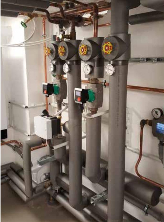
Rohrisolierungen verhindern, dass Wärme dorthin entweicht, wo sie nicht gebraucht wird. So wird das Raumklima optimiert und die Räume sind vorm Überhitzen geschützt. Foto: Thermaflex/txn
