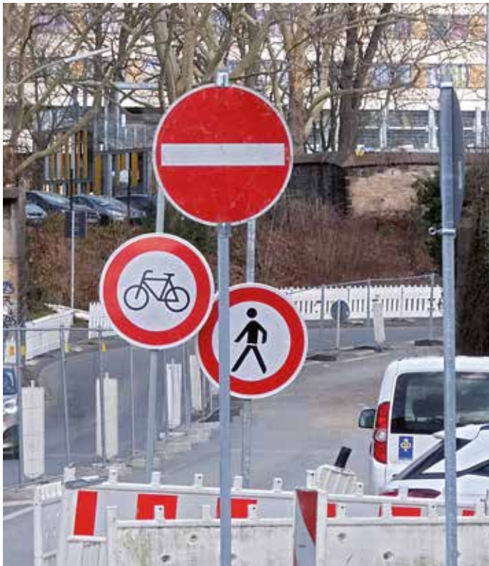
Der geplante Termin der Fertigstellung im Frühjahr 2021 gerät bereits im ersten Bauabschnitt am Anfang der Pferdebachstraße ins Wanken. Die Stadt sei auf „Unvorhergesehenes“ gestoßen wie alte Fundamente oder belasteten Tankstellengrund. Foto: Thomas Strehl
