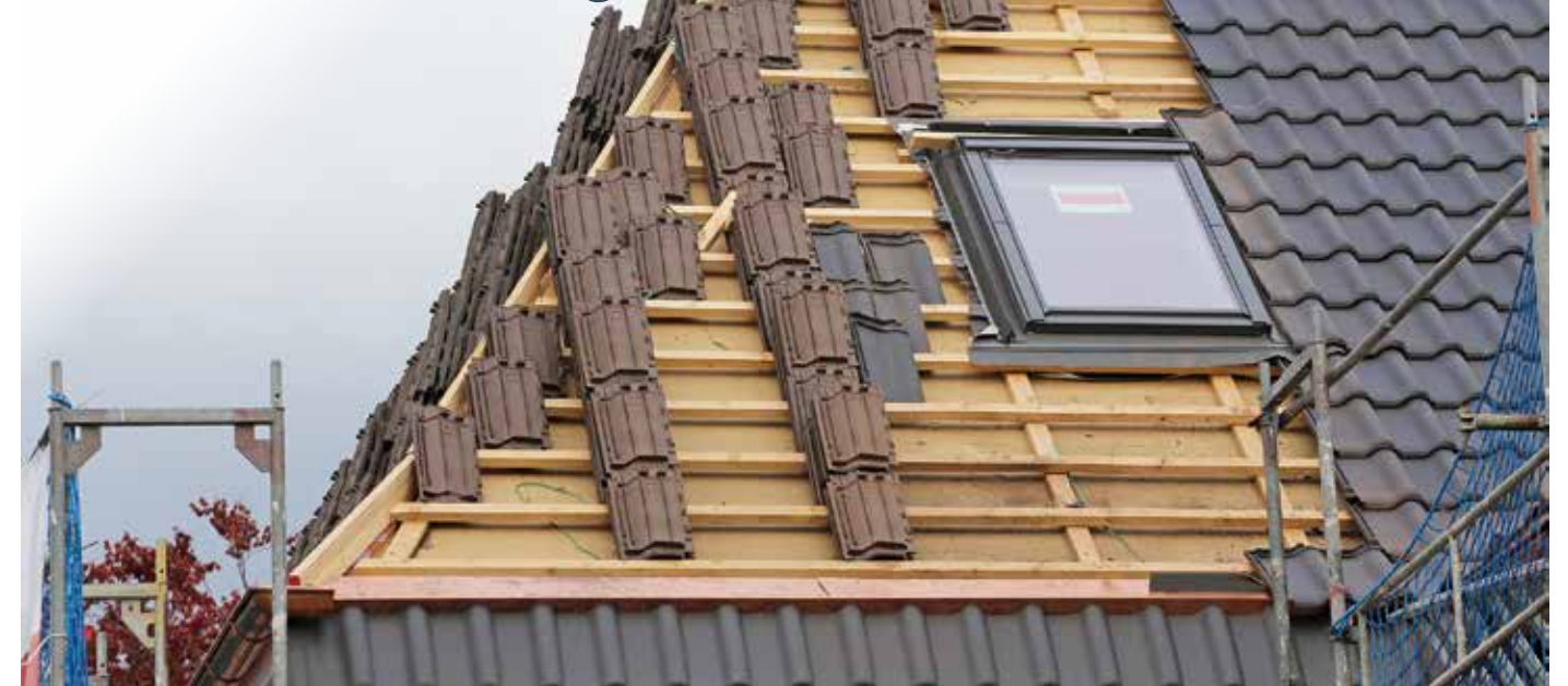
Nach einer Dachsanierung sind Dach und Haus wieder ein optisches Highlight. Eine Dämmung und die neue Dacheindeckung bringen Wärmeschutz und Optik in Einklang. Foto: Adobe Stock
