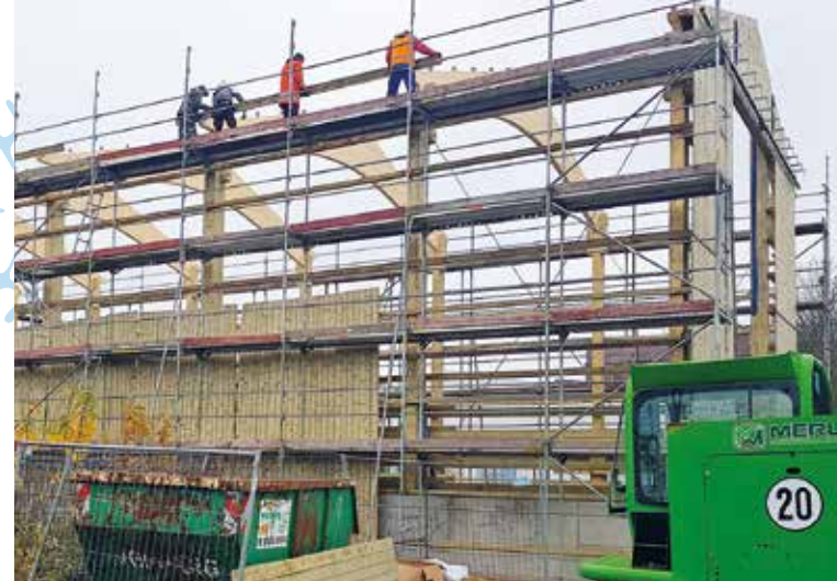
Die neue Salzhalle wird bis auf das Fundament komplett aus Holz gebaut. Foto: Petra Ortwein
