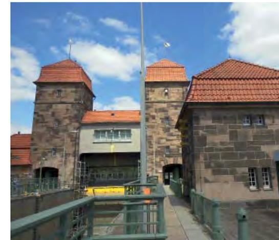
Die imposante Schachtschleuse überwindet den Höhenunterschied von etwa 13 m zwischen Mittellandkanal und Weser. Sie wurde in den Jahren 1911–1914 mit einer nutzbaren Kammerlänge von 82 m und einer Breite von 10 m als massives Bauwerk errichtet
