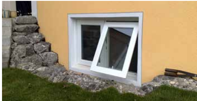
Wasserdichte Hochwasserschutzfenster schützen bei Starkregen und Überflutungen.
