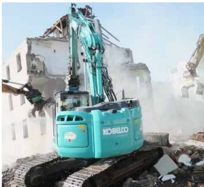
Staub und Dreck: Abrissbagger „knabbern“ an der Osterfeldstraße
