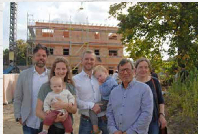
Am ersten Haus des Wohnprojekts „Wohnen im Lindenhof“ wurde Richtfest gefeiert. Die Projektbeteiligten und die neuen Eigentümer freuen sich darüber. Rechts im Bild: die alte Linde, die Namensgeber für das Projekt war.
