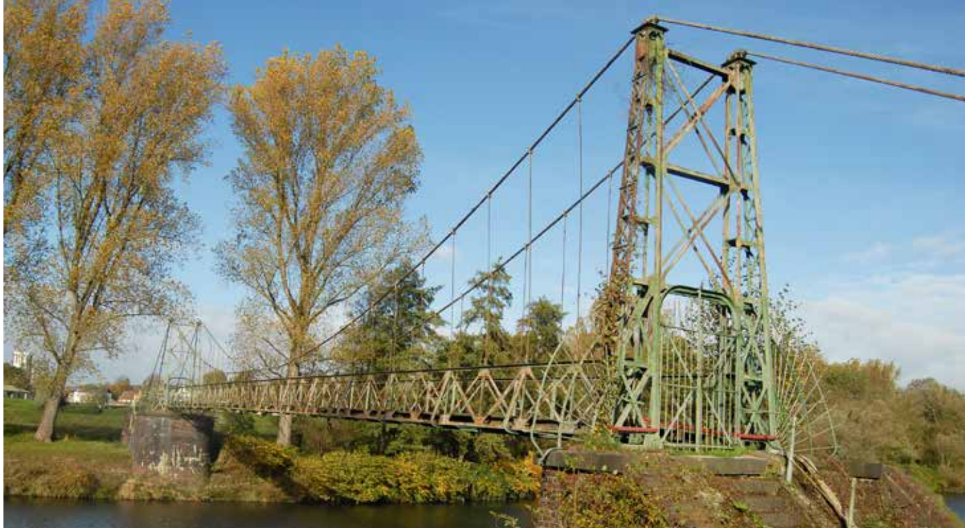
Die denkmalgeschützte Seilbrücke wird von der AVU saniert.
