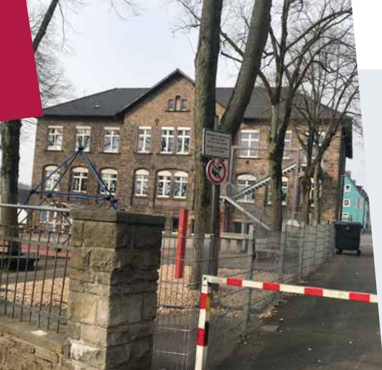
Knapp 4,3 Millionen Euro fließen in den Umbau und die Sanierung der Grundschule an der Bergstraße.
