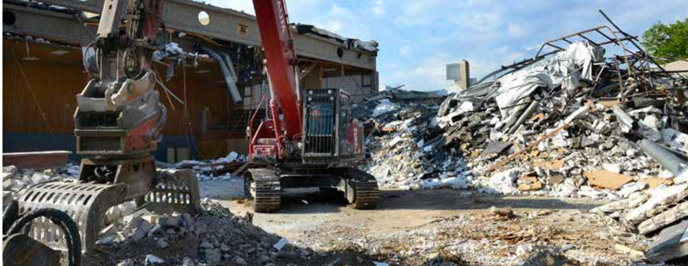
Die Horst-Schwartz-Halle neben der Grundschule am Vormholzer Ring wird in den Sommerferien 2022 abgerissen. Der Autokran kam aus Platzgründen nicht zum Einsatz.
