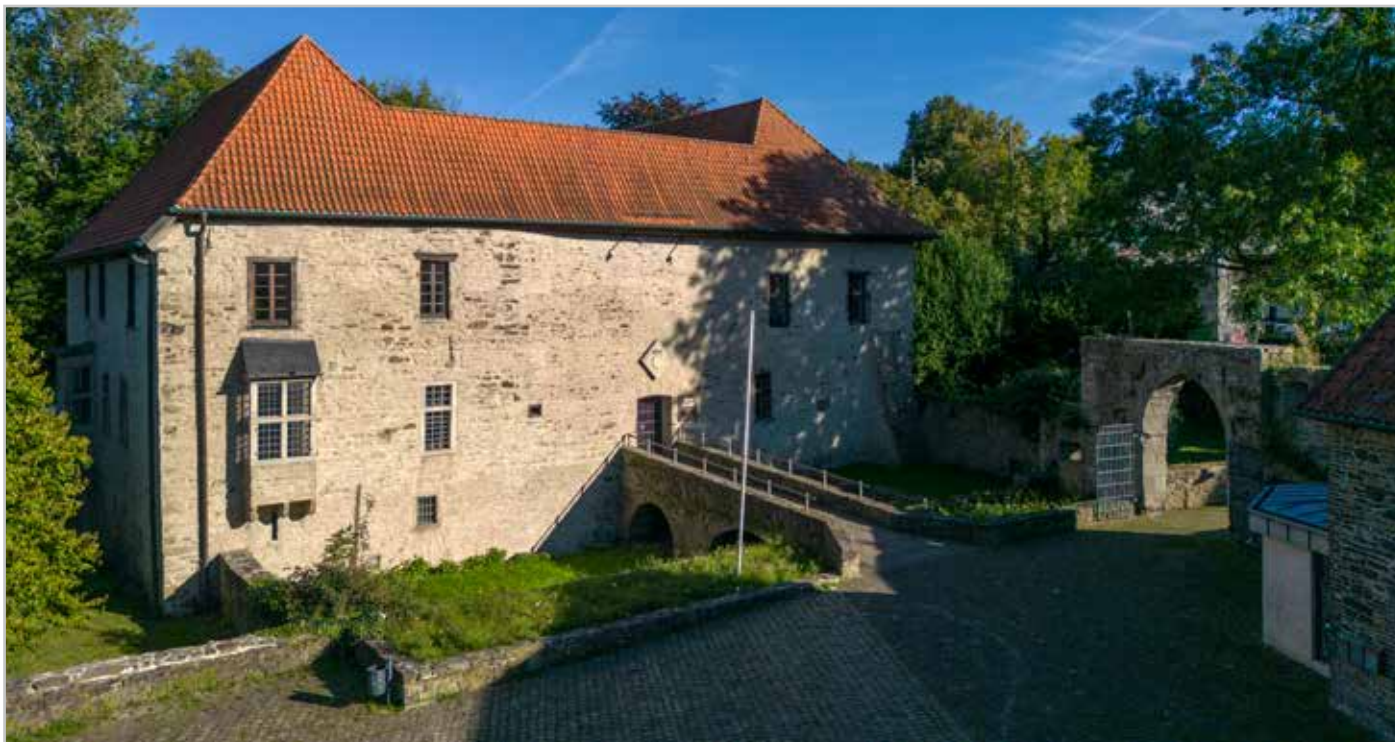
Das historische Gebäude soll zukünftig von mehreren Stellen erleuchtet werden.
