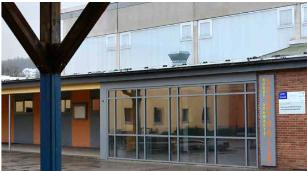
Seit Januar 2020 gesperrt, im vergangenen Jahr abgerissen – die Horst-Schwartz-Halle. Bis eine neue Halle steht, wird es noch einige Zeit dauern.
