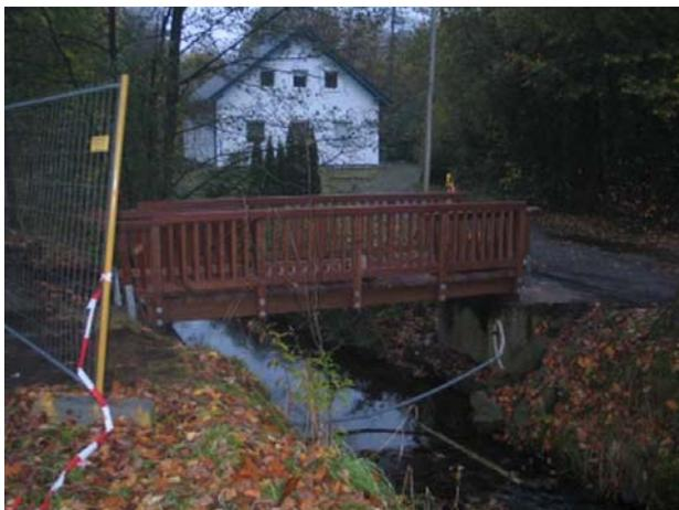
Die Fußgängerbrücke des „Schwester-Huberta-Weges“ und die Fußgängerbrücke an der Straße „In der Trift“ wurden in der zweiten Jahreshälfte 2008 erneuert. Die Brücken waren abgängig und nicht mehr ausreichend verkehrssicher. Die vorhandenen Stahl-Holzkonstruktionen wurden durch reine Holzkonstruktionen ersetzt. Darüber hinaus wurde die Brücke „Schwester-Huberta-Weg“ hoch-
