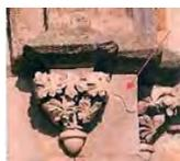
„... Vorrangig sollte die Westfassade für eine Bearbeitung ins Auge gefasst werden. Neben der Erneuerung des gesamten Fugenwerks ist die Sicherung/Erneuerung von Altvierungen und Altergänzungen ... erforderlich .... Rostsprengungen gefährden auch die Schmuckelemente der Portale. ...“
