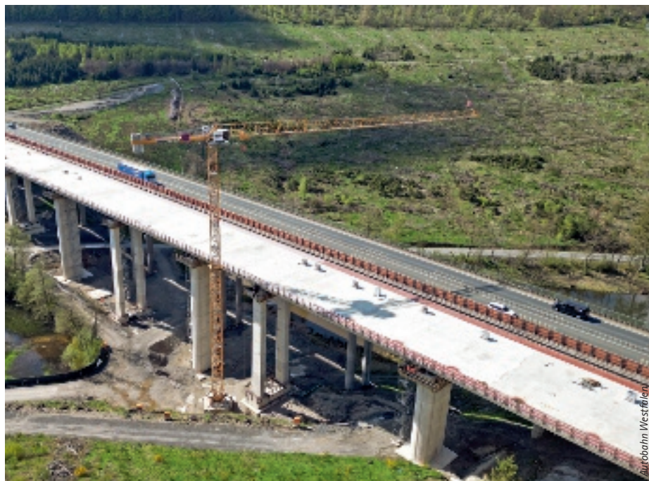
Das erste Teilbauwerk der Talbrücke Landeskroner Weiher steht.
