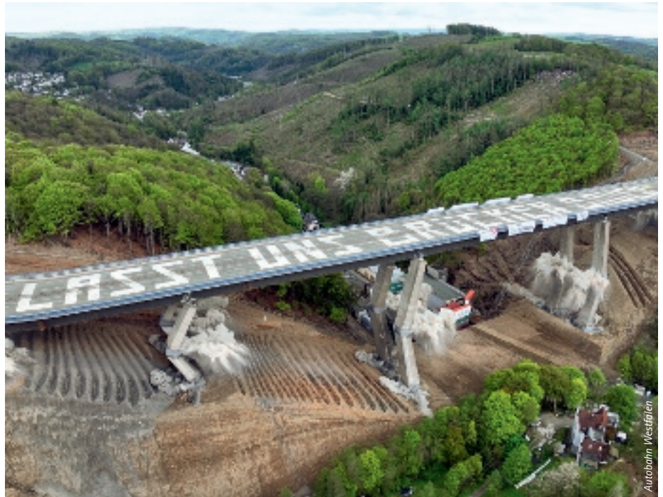
Die Talbrücke Rahmede wurde gesprengt, doch die Probleme für die Region bleiben bestehen.
