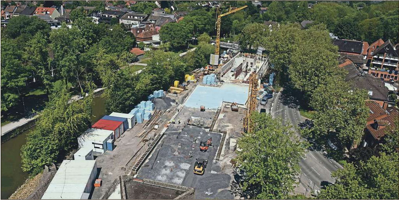
Die imposante Stadthaus-Baustelle vom Dach des Ahlener Rathauses aus betrachtet: Im Norden ragen bereits erste Säulen in die Höhe. Auf ganzer Länge zeichnet sich inzwischen der Grundriss ab. Foto: U. Gösmann
