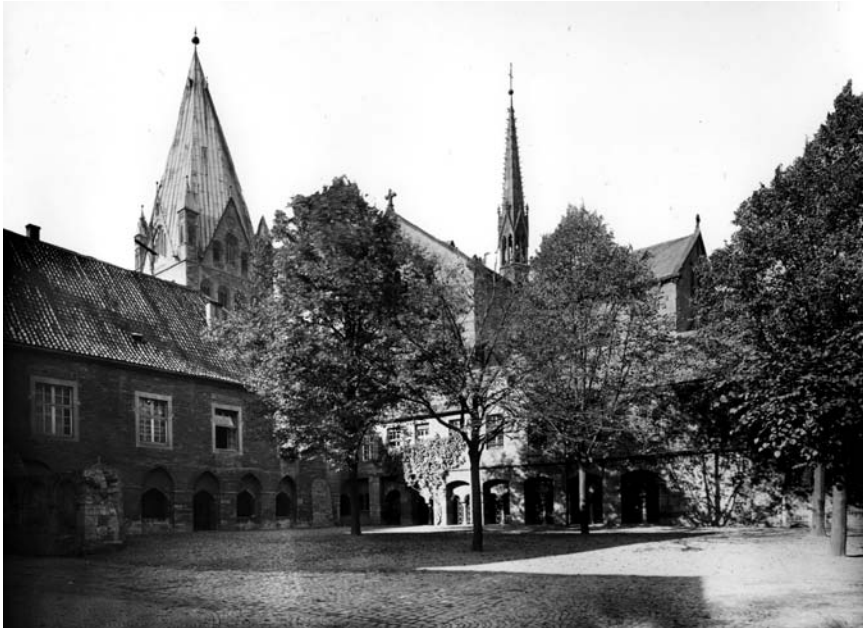
Abb. 3: Kreuzgang vom Südosten mit Resten des Südflügels, vor 1953. Foto: Stadtarchiv Soest
