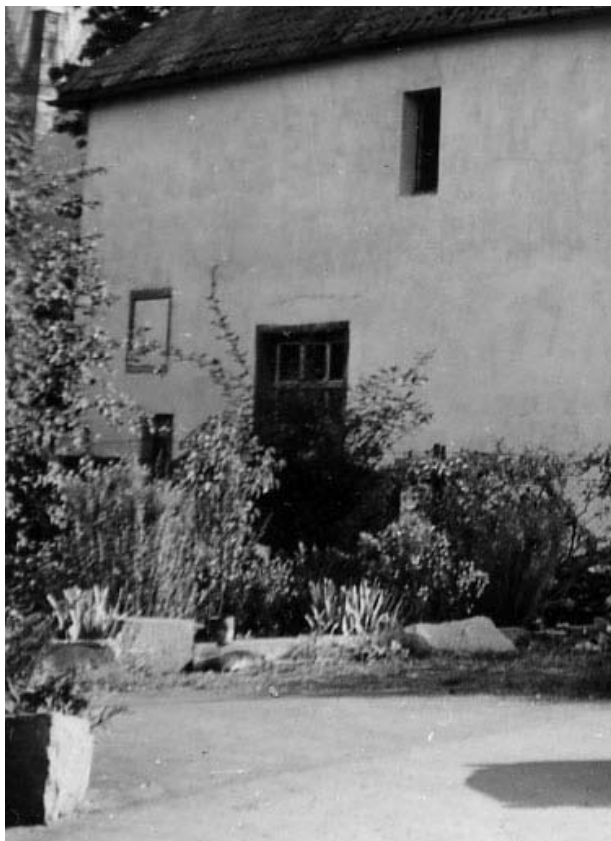
Abb. 4: Zugemauertes Fenster des mittelalterlichen Steinbaus in der Westseite des Hauses Jakobstraße 13, ca. 1960. Foto: Stadtarchiv Soest
