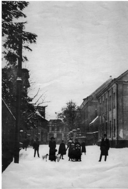
Soest: Partie in der Thomästraße, 1910
