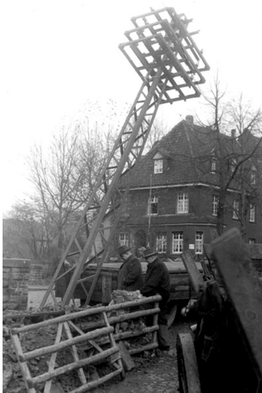
Der starke Eisengittermast von 1909 am Soestbach beim Abbau 1953
