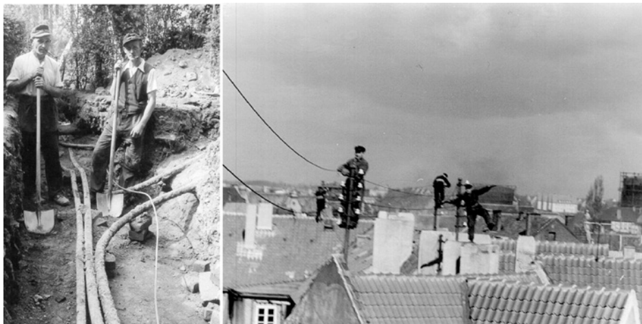
Links: Arbeiten im Kabelgraben;
