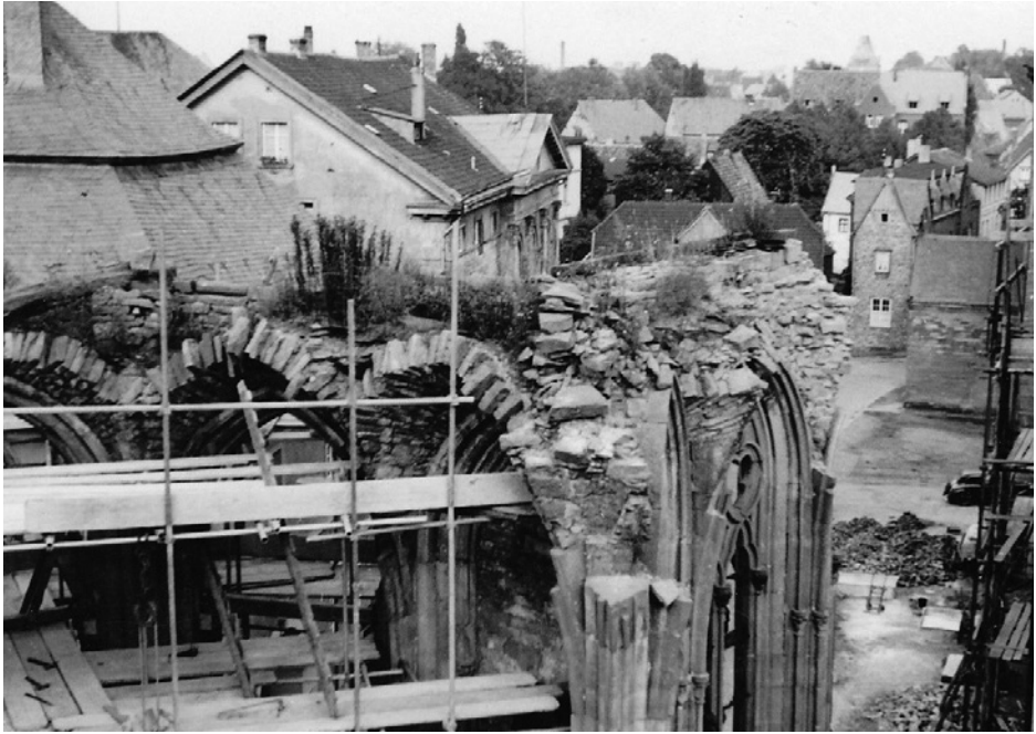
Nach Jahren ist die Chorruine der Petrikirche mit Unkraut überwuchert. Die Arbeiten an St. Patrokli gehen zügiger voran
