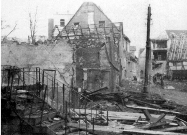
Einsamer Leitungsmast in der Osthofenstraße
