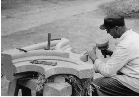
Ein Steinmetz bei der Bearbeitung des gotischen Maßwerks. Der Wiederaufbau des Chores kam einem Kirchenneubau gleich
