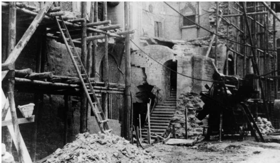
Beginn der Wiederrichtung der Nordwand
