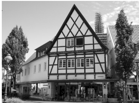
Abb. 4: Walburgerstraße 26, Blick von der Waisenhausstraße, links im Bild der Anbau anstelle von Haus Nr. 24. Foto: Verf.
