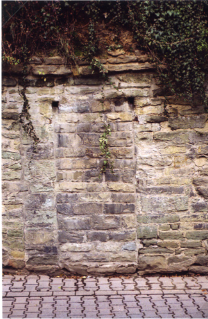
Abb. 6 und 7: Zugemauerte Türen an der Stadtseite der Schonekindbastion, Nötten-Brüder-Wallstraße. Foto: Verf.
