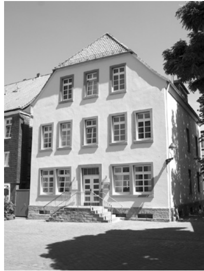
Abb. 9: Am Vreithof 6, heutiger Zustand. Foto: Verf.
