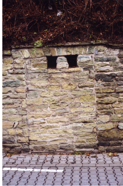
Abb. 6 und 7: Zugemauerte Türen an der Stadtseite der Schonekindbastion, Nötten-Brüder-Wallstraße. Foto: Verf.
