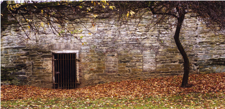
Abb. 1: Gewölbetür im Osthofen-Thomä-Wall. Foto: Verf.
