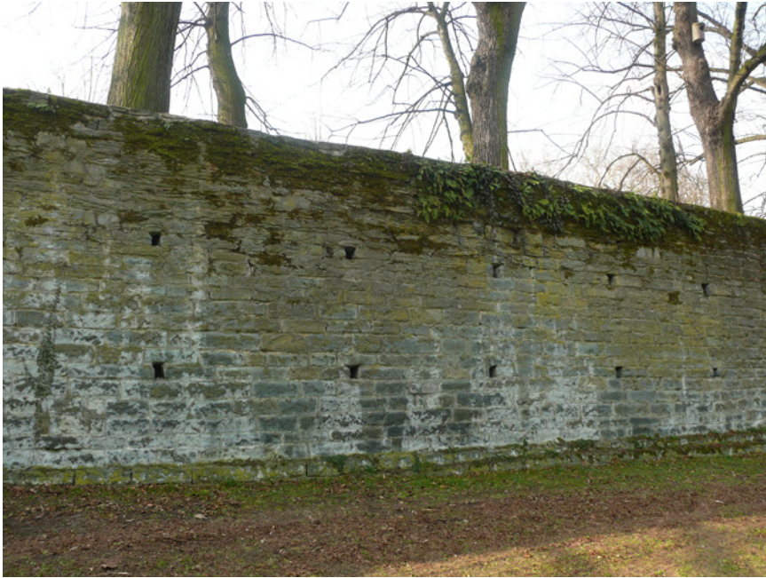
Abb. 2: Löcher als Überreste der Anbringung von Steckgerüsten (Osthofen-Thomä-Wall).
