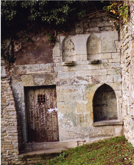
Abb. 2: Reste der Bastion am Grandwegertor. Foto: Verf.
