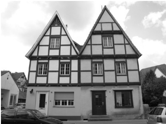
Abb. 5: Thomästraße 14 und 16 als Reminiszenz an die „Giebelstadt“ Soest. Foto: Verf.
