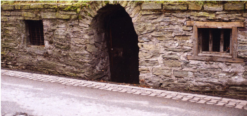
Abb. 4: Gewölbetür und Fenstergitter in der Jakobi-Nöthen-Wallstraße. Foto: Verf.
