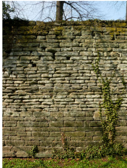
Abb. 5: Steinlagen in unterschiedlicher Bearbeitungsqualität (Thomä-Grandweger-Wall). Foto: Verf.
