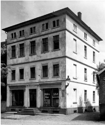
Abb. 8: Am Vreithof 6, Zustand der 1950er-Jahre nach Entfernung der Zierelemente. Foto: Stadtarchiv Soest, Bildarchiv
