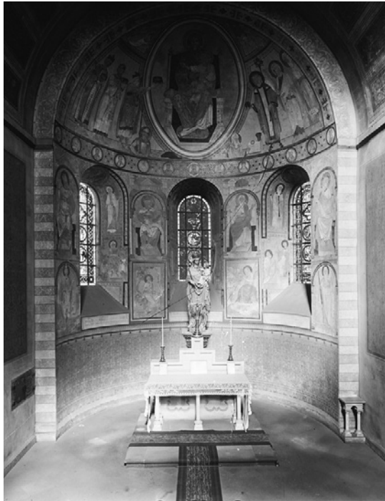
Abb. 5: Soest, St. Patrokli: Nördliche Seitenapsismalerei 1904 (Marienchörchen). Foto: Brandenburgisches Landesamt für Denkmalpflege, Meßbildarchiv
