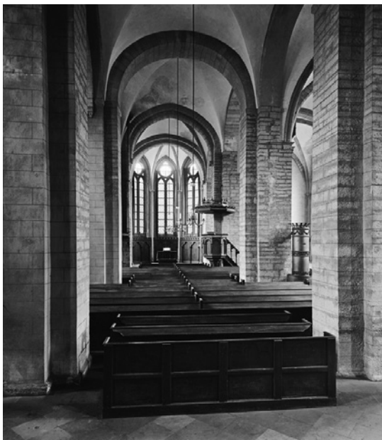
Abb. 3: Soest, Alt-St.-Thomä: Gewölbe im östlichen Mittelschiff 1904. Foto: Brandenburgisches Landesamt für Denkmalpflege, Meßbildarchiv
