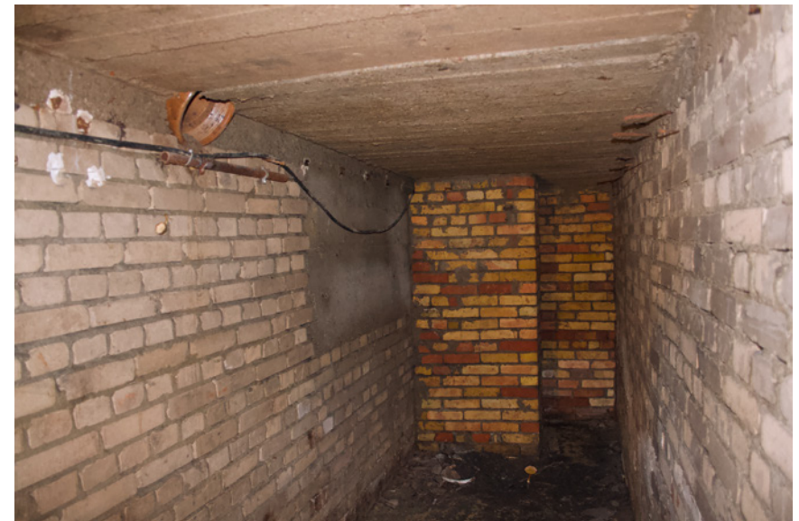
Abbildung 1: Blick in die Südostsektion des Stollens mit seiner Mischung aus Mauerwerk und Betonabschnitten. Foto: Verf.
