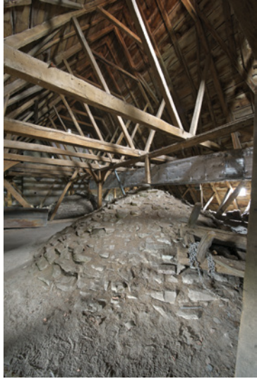
Abb. 11: Lohne, evang. Pantaleonskirche. Vermutlich bauzeitliches Dachwerk über dem Langhaus. Blick nach Nordwesten, im Vordergrund das östliche Mittelschiffgewölbe. Foto: Pieper.
