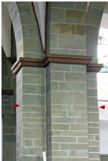
Abb. 9: Lohne, evang. Pantaleonskirche. Nördlicher Freipfeiler. Die beiden Pfeile markieren die ursprüngliche Höhe bzw. darüber die Aufhöhung. Foto: Pieper
