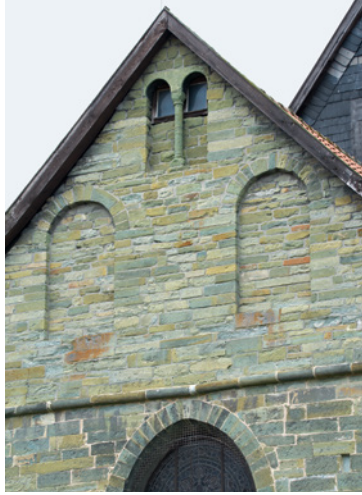
Abb. 5: Lohne, evang. Pantaleonskirche. Ostgiebel des Chores mit Bogenblenden und teilvermauertem Fenster, 2020. Foto: Pieper
