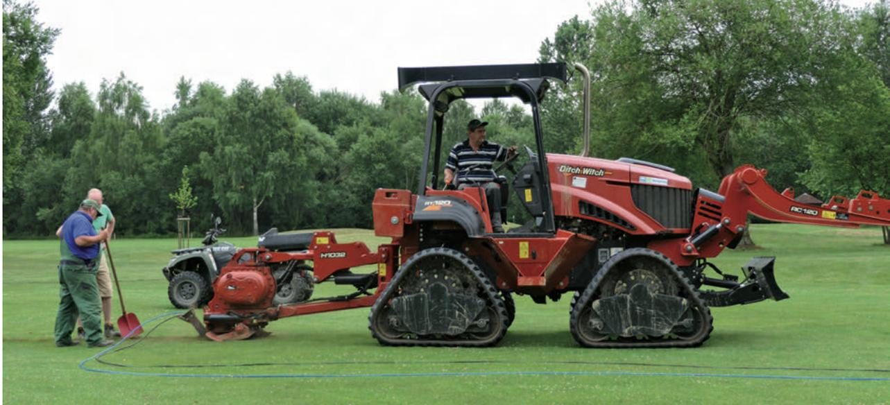
*Mit Spezialgeräten wird der Platz behutsam „aufgeschlitzt“ und gleichzeitig die langen Wasserrohre mit den entsprechenden Steuerleitungen eingezo-*
