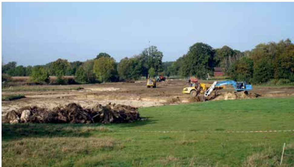
Die Geländeprofilierung hat begonnen
