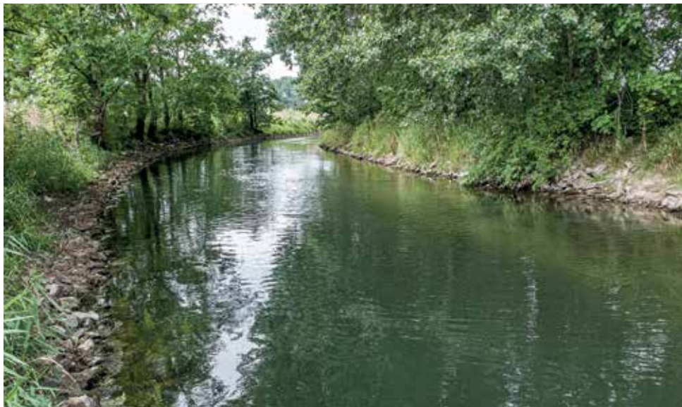
Die Uferböschungen sind durch Steinschüttungen befestigt.
