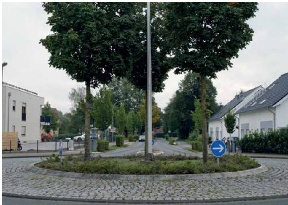
Die Kreisverkehrsanlage mit Blick aus Richtung Ostenland
