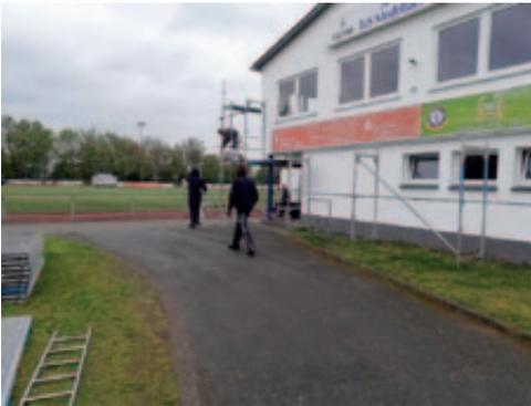
Bilder: Gerüstabbau mit mehreren Helfern
