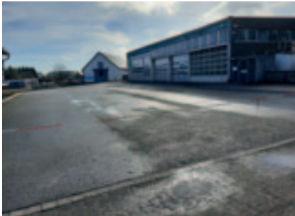
Das Kleinbahngelände, hier ein Bild von der Bahnhofstraße, „ziert“ seit einiger Zeit eine Absperrung.
