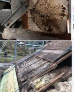
Anschließend wird die Dachfläche verschalt und die Unterdeckung aufgebracht. Mitte/Ende Mai werden die Dacharbeiten fortgesetzt und sollen Ende August/Anfang September beendet werden. Bereits Mitte Juni ist der der restauratorischen Beginn Maßnahmen an den Deckengewölben vorgesehen und Anfang September wird die Orgel wieder eingebaut. Soweit der Plan...
