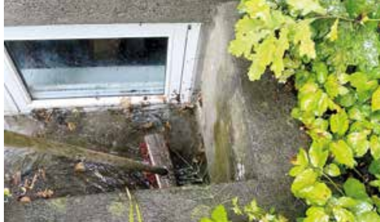
Wer rechtzeitig die Anschlüsse der Kellerfenster abdichtet, minimiert bei Hochwasser das Risiko von Wasserschäden im Gebäude. Foto: Scharvik/istockphoto.com/Triflex/akz-o
